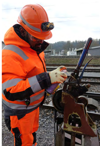
Schmieren und ölen der gereinigten Weichen
