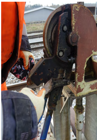
Schmieren und ölen der gereinigten Weichen
