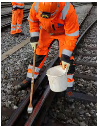
Schmieren und ölen der gereinigten Weichen
