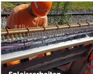
Spleissarbeiten an Kabelverteiltern
