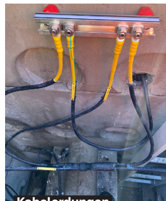
Kabelerdungen in Kabelschacht
