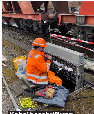
Kabelbeschriftung an Verteilern
