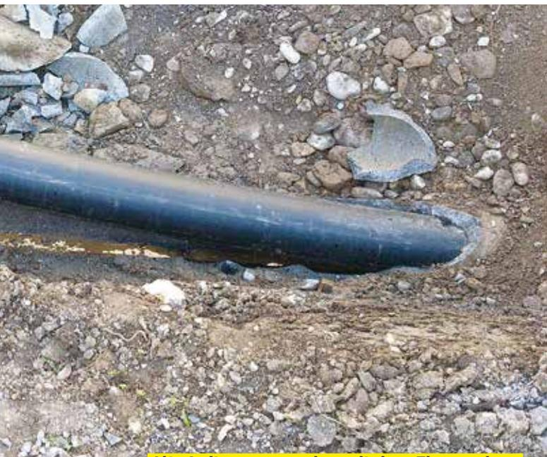
**Alte Leitungen werden mit dem Einzug eines Neurohres dauerhaft und umfassend erneuert**
