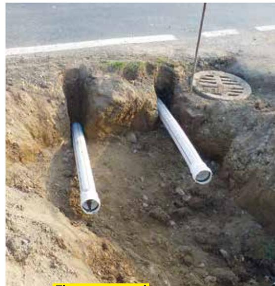
**Einzug von zwei Kabelschutzrohren**
