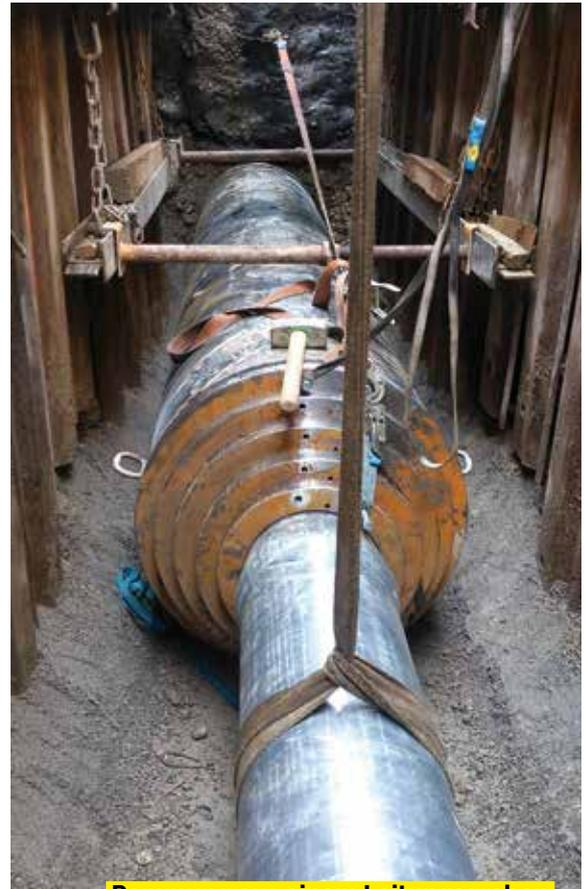
**Rammung aus einem Leitungsgraben vor dem Verlegen der Abwasserrohre**
