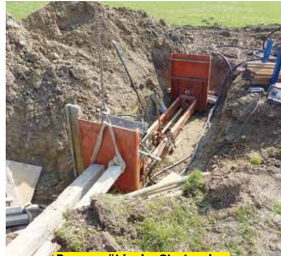
**Pressgerät in der Startgrube, montiert für den Einzug von Kabelschutzrohren**
