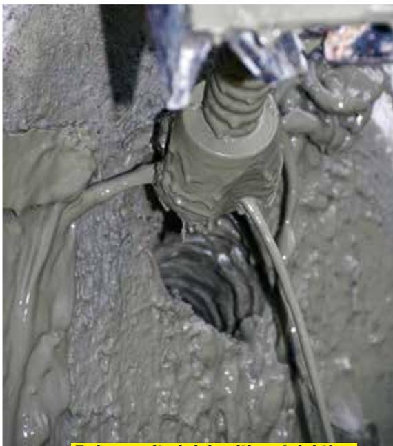
**Bohren mit gleichzeitiger Injektion
