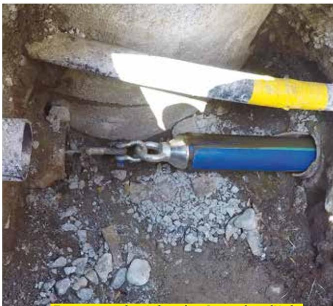
**Erneuerung bestehendes Gussrohr mittels Erdrakete zum Aufbrechen von Kalkrückständen und anschließendem Einzug des neuen Mediumrohres**
