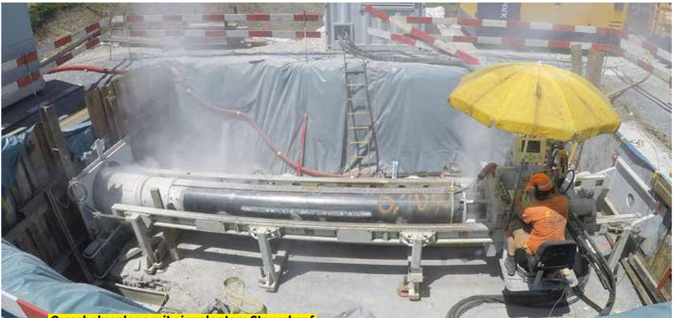
**Grossbohranlage mit eingelegtem Steuerkopf**
