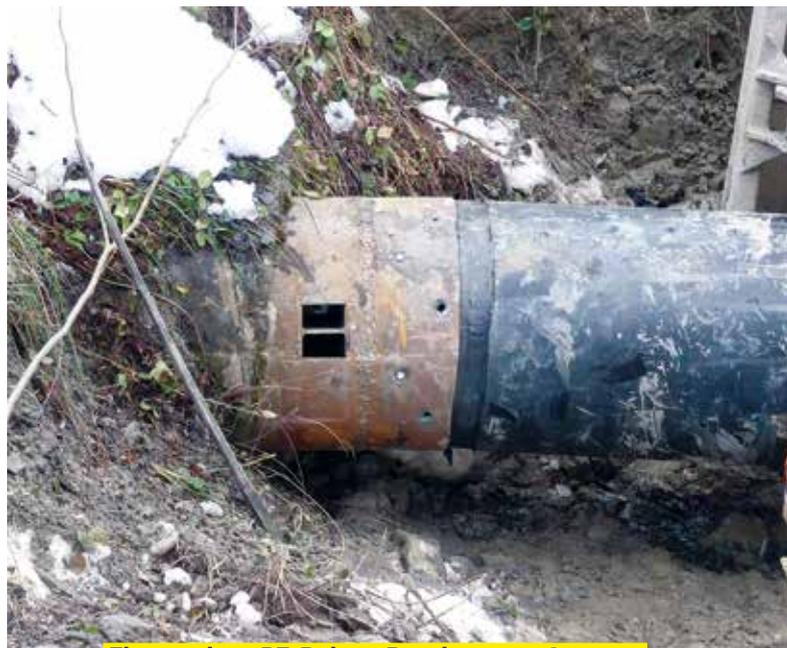
**Einzug eines PE-Rohres Durchmesser 800 mm in ein bestehendes Zementrohr**
