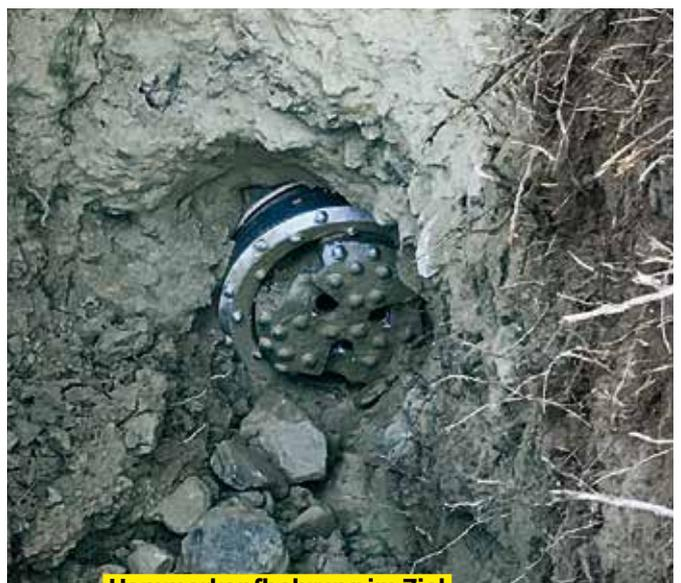
**Hammerkopfbohrung im Ziel**
