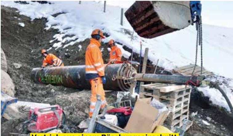
**Vortrieb aus einem Böschungseinschnitt**
