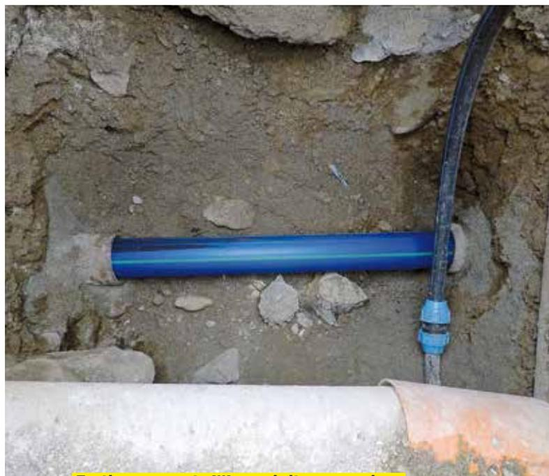
**Fertig erneuerte Wasserleitung vor dem Anschluss der Hauszuleitung**
