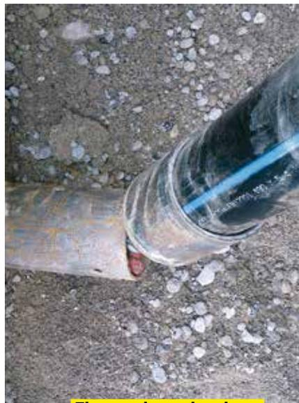
**Einzug eines einzelnen Kabelschutzrohres**
