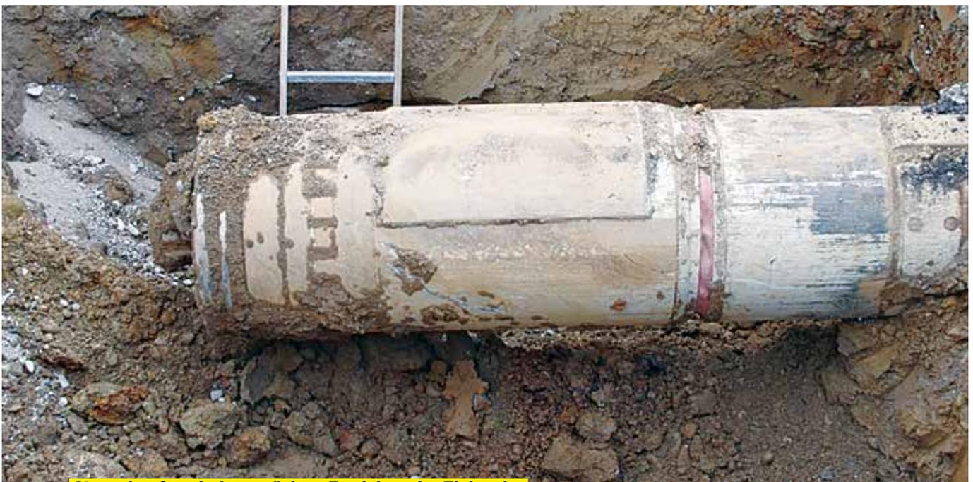
**Steuerkopf nach dem präzisen Erreichen der Zielgrube**
