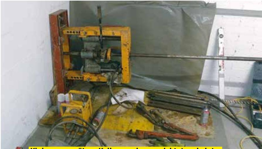
**Kleinpressgerät, an Kellerwand ausgerichtet und platzsparend montiert, für gesteuerte Pilotbohrung mit direktem Einzug des Mediumrohrs ins Erdreich**
