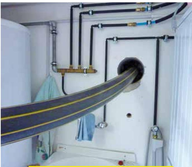
**Kabelschutzrohr beim Einzugsvorgang für einen neuen Stromanschluss**
