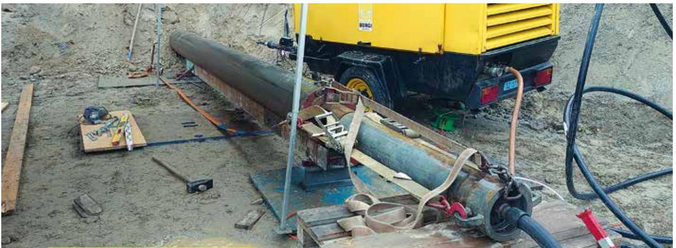
**Rammvortrieb aus einer Baugrube**
