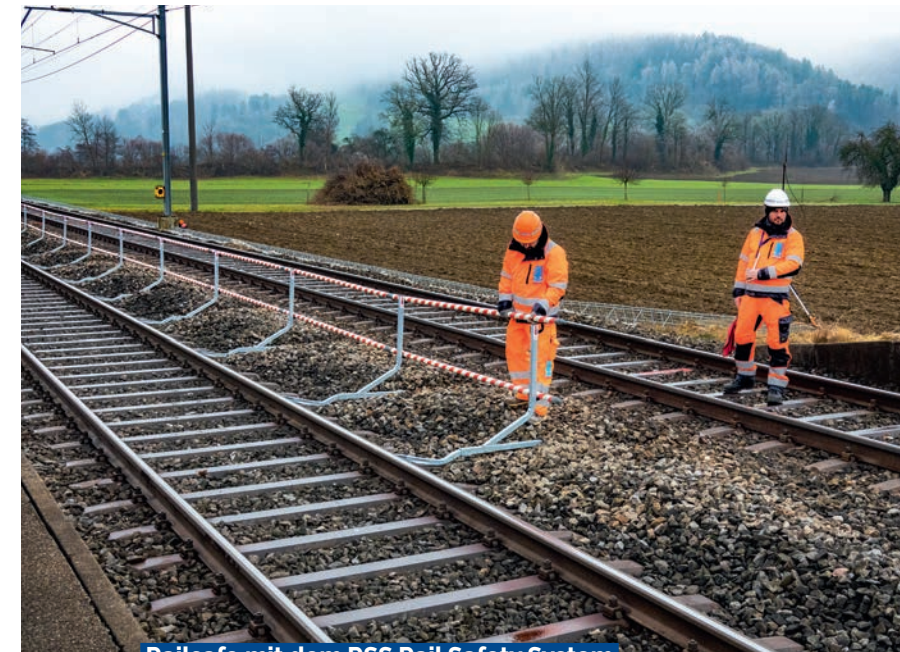
Railsafe mit dem RSS Rail Safety System
