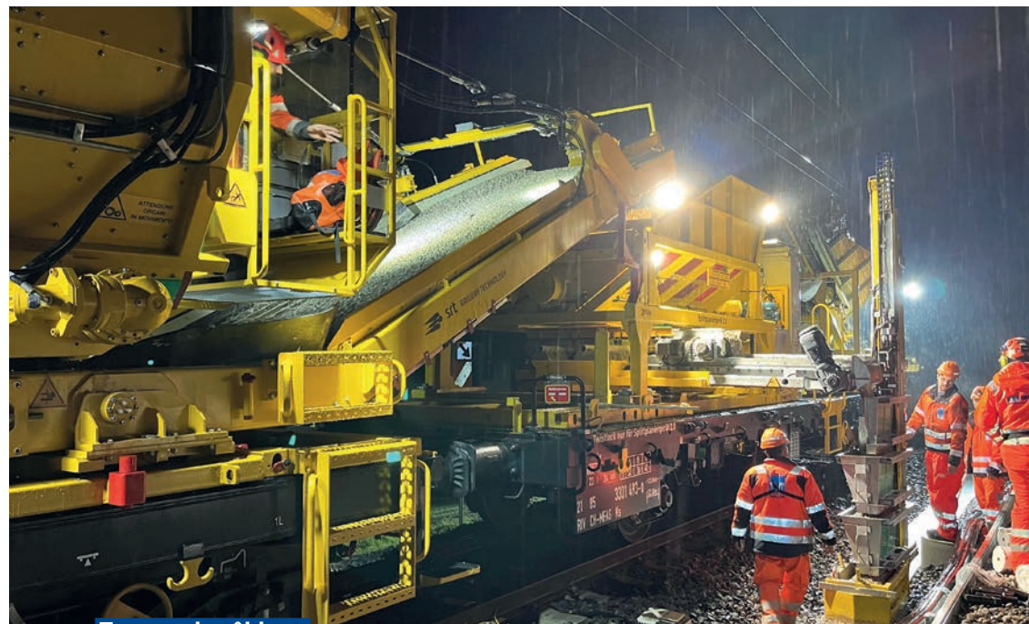
Travaux de câblage
