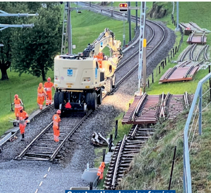
Construction de voies ferrées
