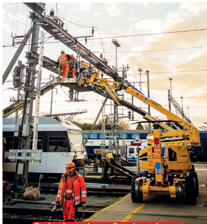
Engins de montage rail-route modernes
