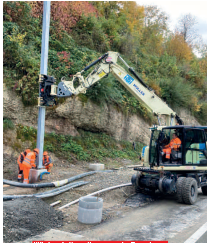
Wir begleiten die gesamte Bauphase
