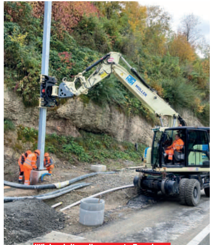
Wir begleiten die gesamte Bauphase
