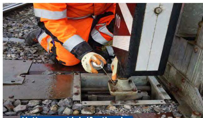
**Nettoyage et lubrification des aiguillages et des signaux**
