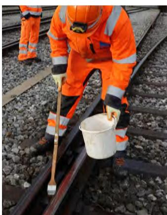
**Graissage et lubrification des aiguillages nettoyés**
