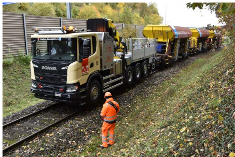
Transportarbeiten mit Fernbedienung
