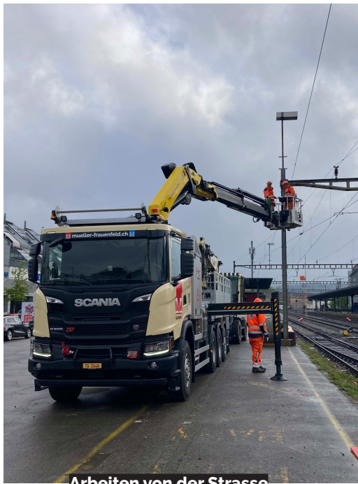
Arbeiten von der Strasse
