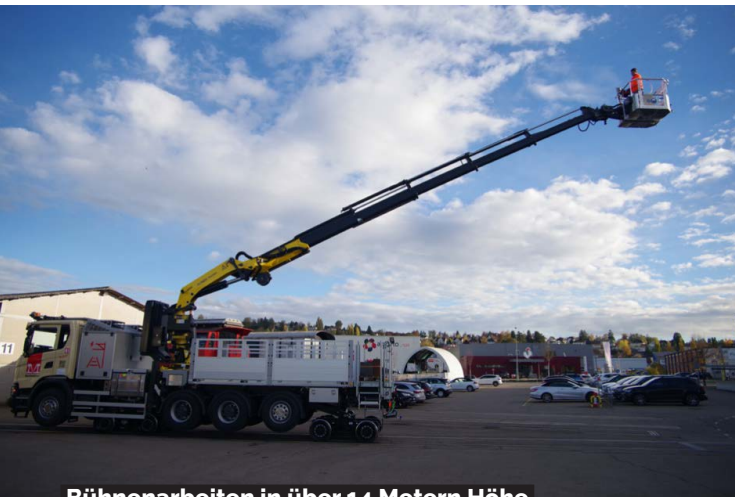
Bühnenarbeiten in über 14 Metern Höhe
