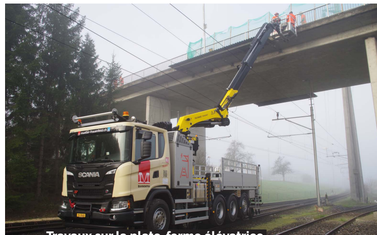
Travaux sur la plate-forme élévatrice
