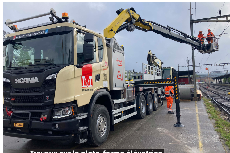
Travaux sur la plate-forme élévatrice
