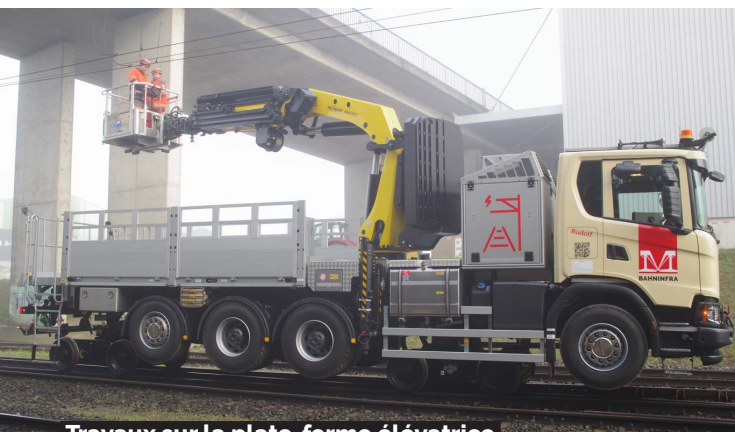
Travaux sur la plate-forme élévatrice
