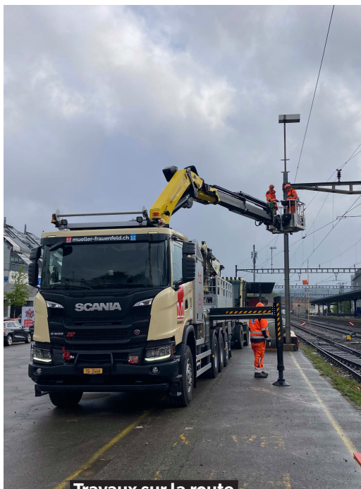
Travaux sur la route
