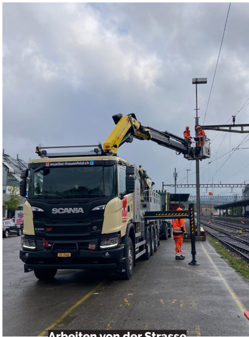
Arbeiten von der Strasse
